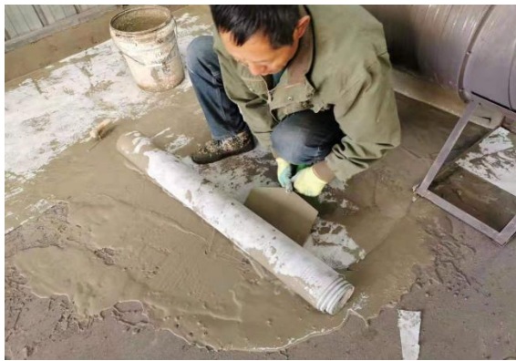
对喷漆房地面进行防渗处理
