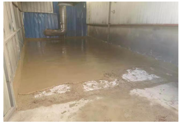
对喷漆房地面进行防渗处理
