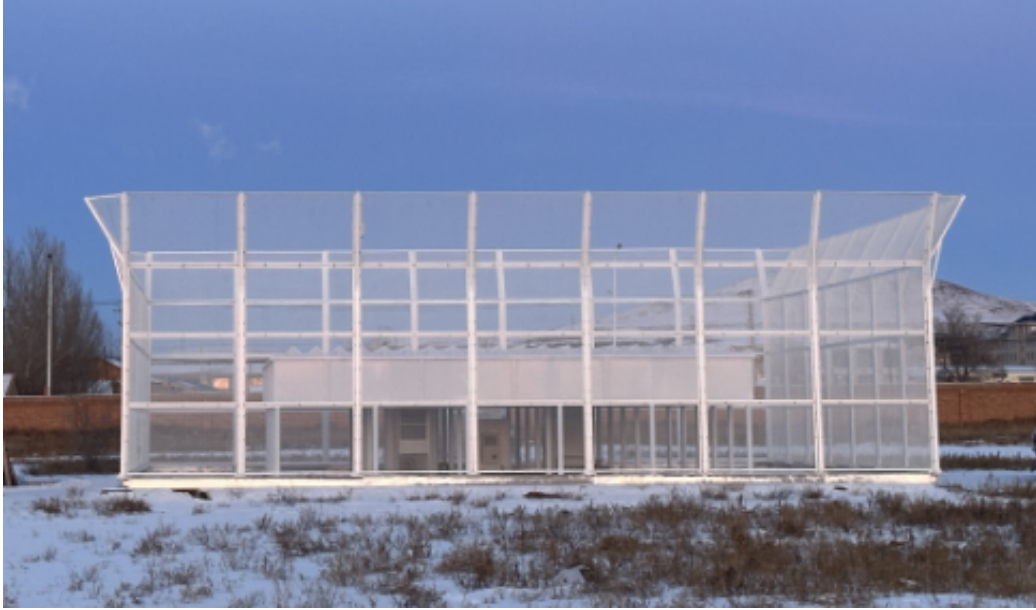
图3.1-1 P波段风廓线雷达外观
