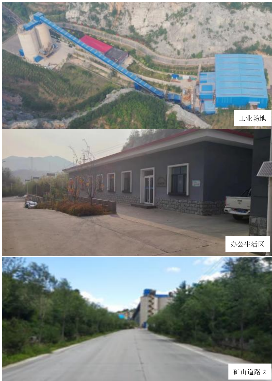
图 3.1-7 现有工程矿石加工厂区现状
