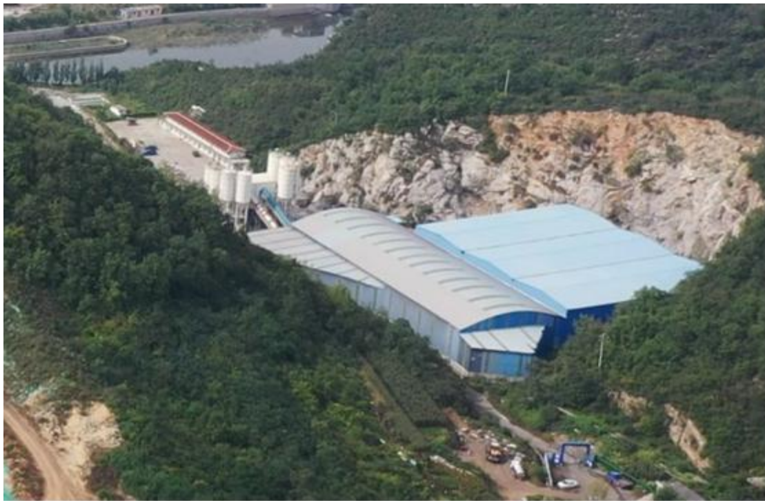
图 3.1-8 现有工程矿区范围内搅拌站现状
