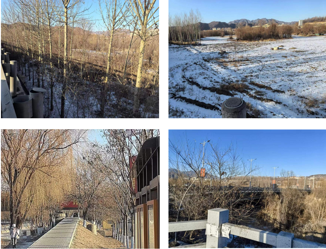
图 3-2 现场踏勘照片
