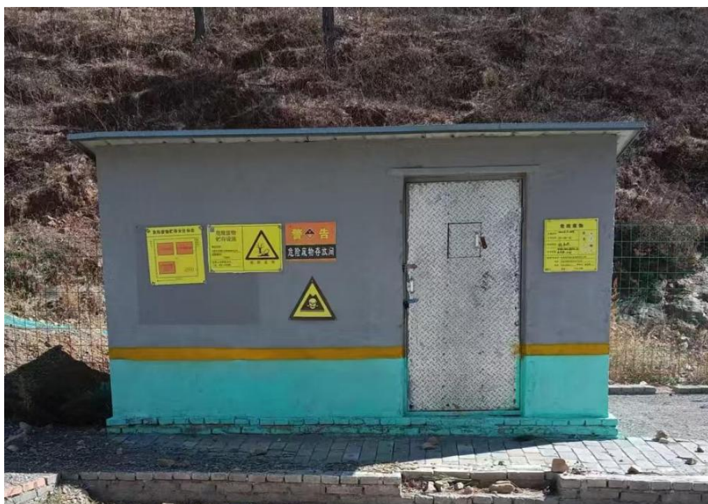
图 2-1 危废间现场照片
