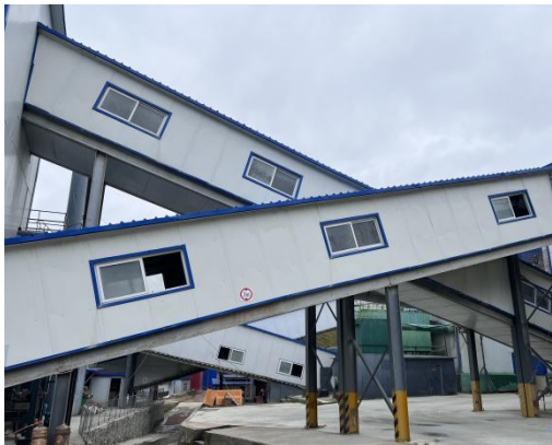
图 9 皮带廊道封闭
