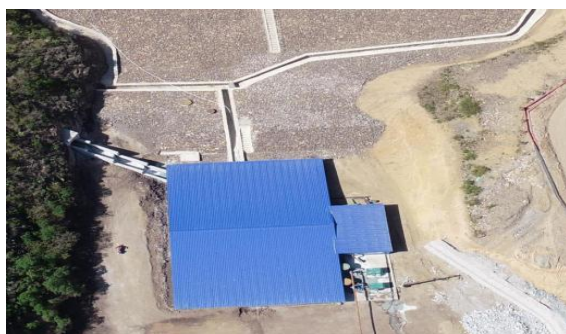
图 3 棚化消力池及坝脚排水沟
