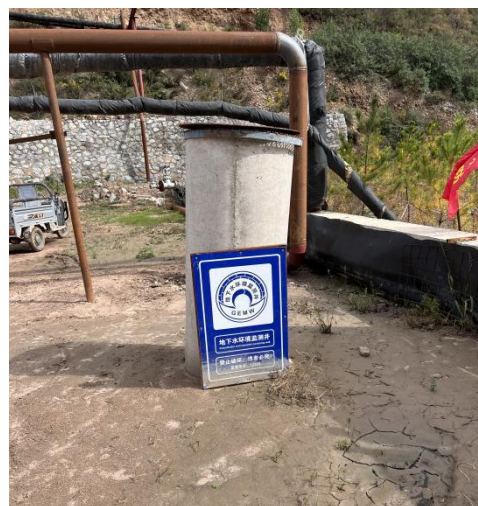
高祥沟尾矿库地下水监测井
