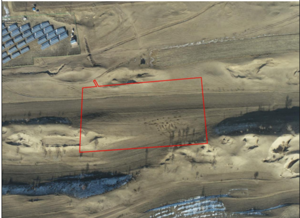
图3-1 升压站原始地貌图（由南向北）
