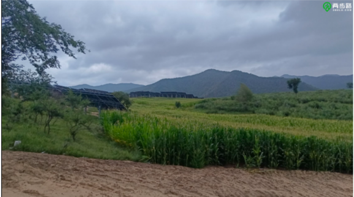
图3-1 拟建升压站现状图
