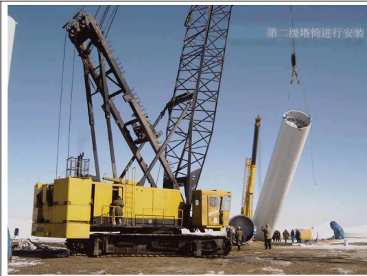
安装中的第二级塔筒
