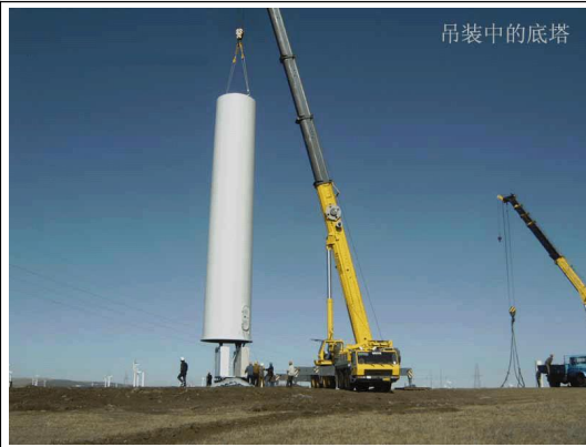
吊装中的底塔
