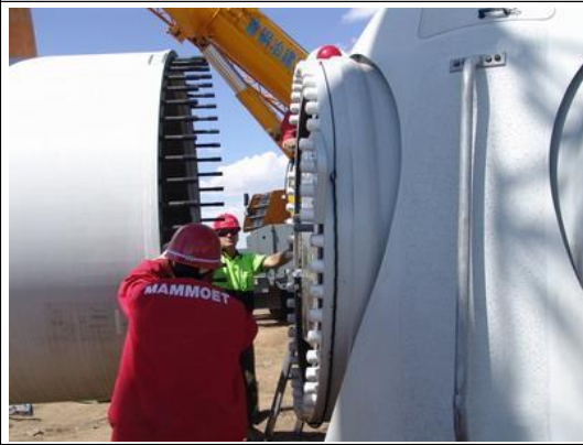
安装中的叶片
