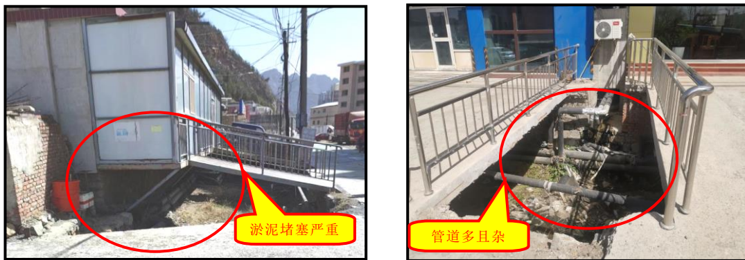
图 2-1-4 大庙沟村涵洞现状图
