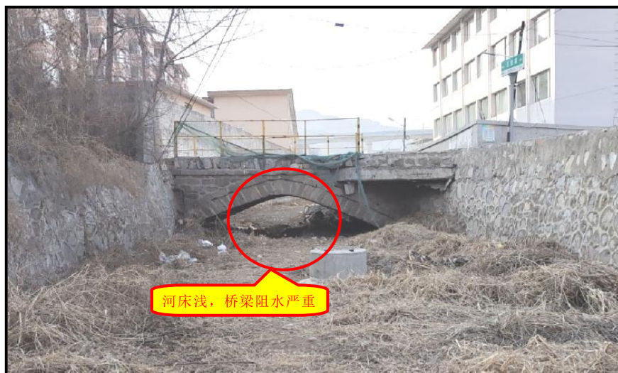
图 2-1-3 车道沟村修复加固桥梁现状图
