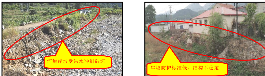
图 2-1-2 典型河道岸坡现状图
