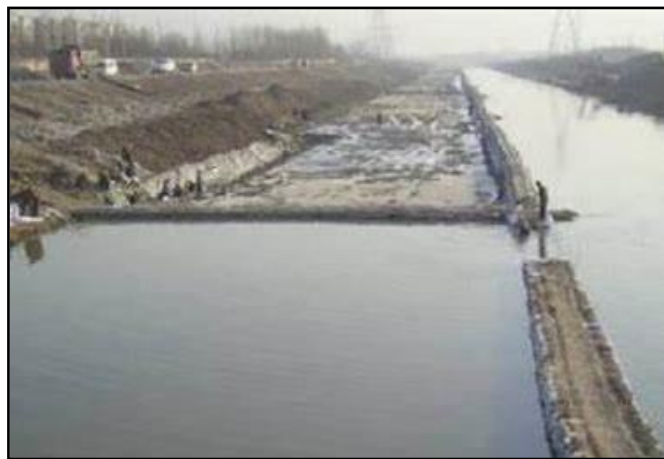
图 4-2-1 同类项目围堰施工示意图
