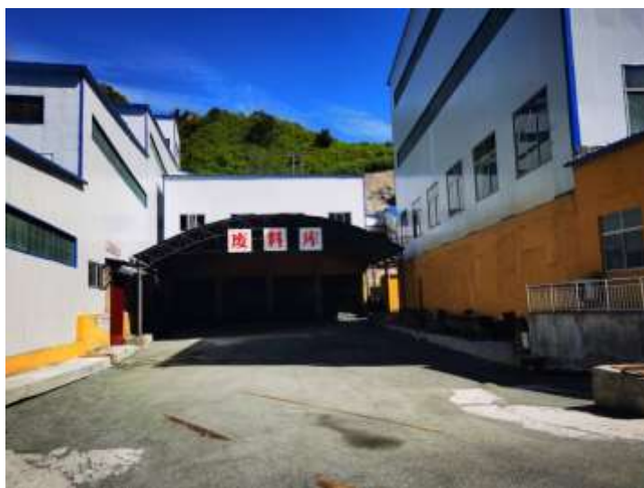
图 3.1-3 废料库未封闭情况
