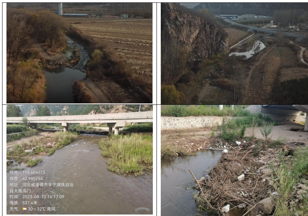
图 3-2 大南沟门村至大草坪村段河道现状图
