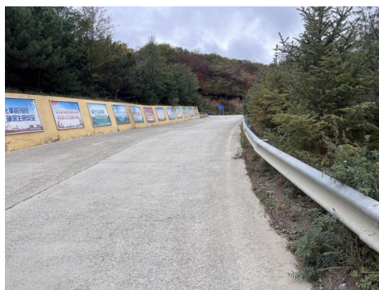
图 12 厂区道路硬化
