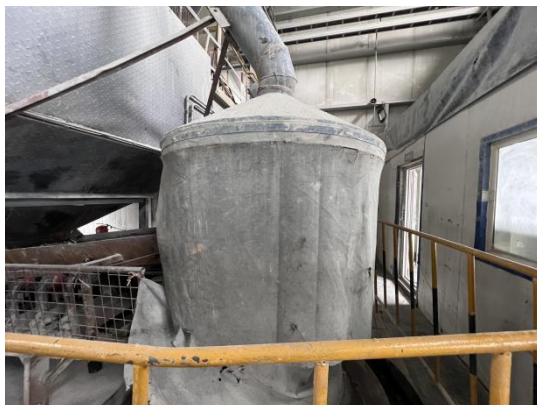
图 6 圆锥破碎机密闭以及管道集尘
