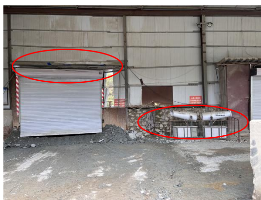
图 2 入料口上方和侧方喷淋设施
