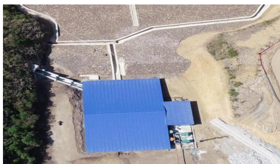
图 3 棚化消力池及坝脚排水沟
