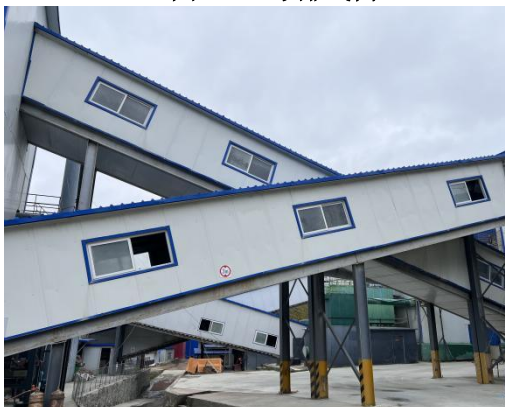
图 9 皮带廊道封闭
