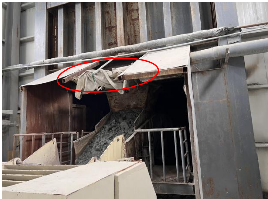
图 5 原矿仓下料口喷淋装置以及集气装置
