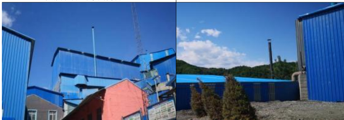
5号除尘器排气筒（2#破碎车间中破和细破）
